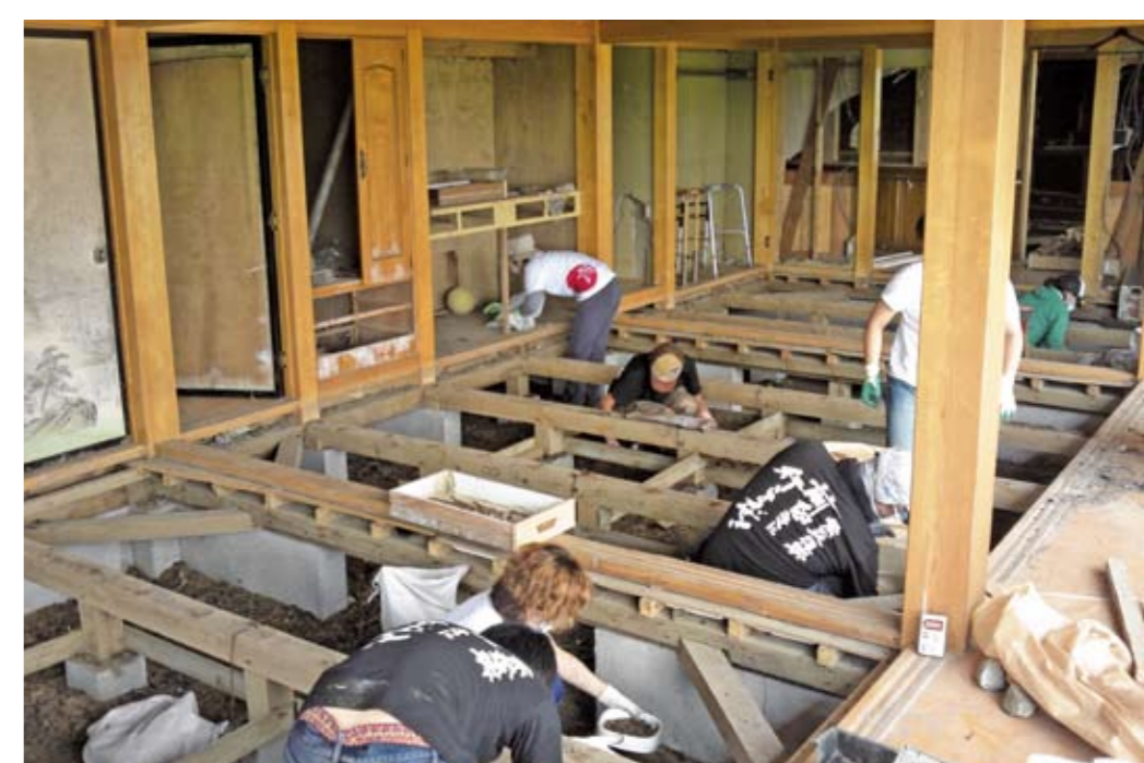
山元町にて民家の瓦礫撤去
